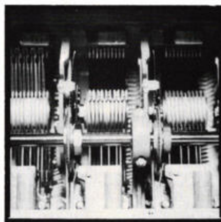
Detail-opname van elektromechanische rotary-kiezer (foto ITT-NSEM). Relaiskasten van ITT's 7 EN-centrale.
